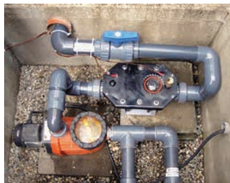
Problemlöser: Der Einbau der Kupfer-Silber-Ionisierungsanlage erfolgte im Pumpenschacht neben den Wasserbecken.
